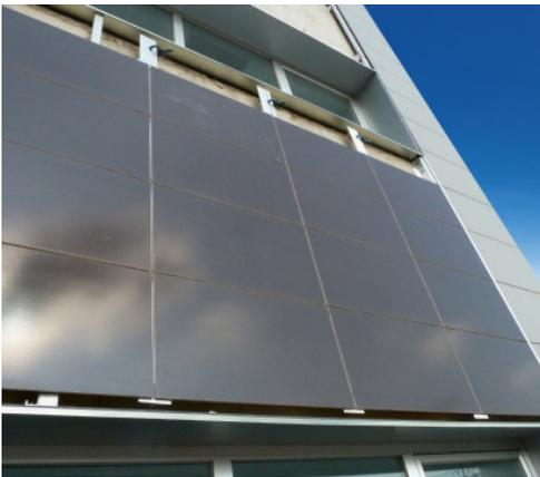
*Mit Cool Tile lässt sich bei der Verwendung an hinterlüfteten Fassaden der Temperaturanstieg reduzieren.
